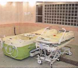
3階・5階機械浴槽
